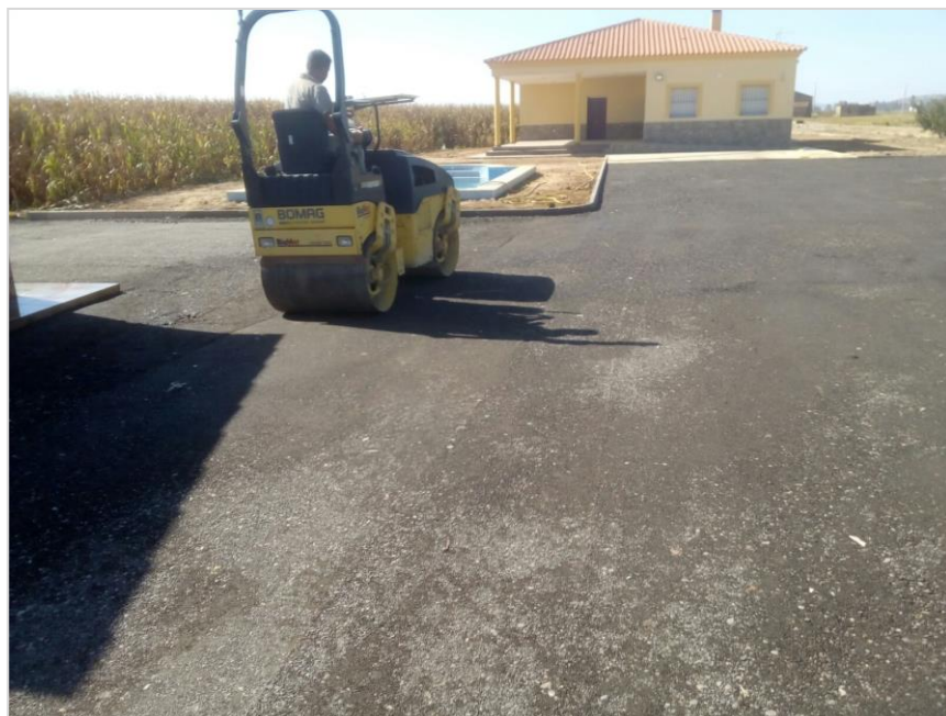
Ilustración 10. Aplicación de árido reciclado en una explanación.
